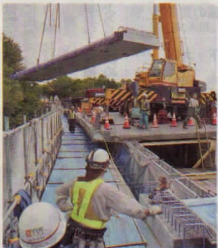
大規模改修工事が行われている札幌道の大野橋。今後は高速道路の「維持更新」が本格化する —小樽市内(小室泰規撮影)
