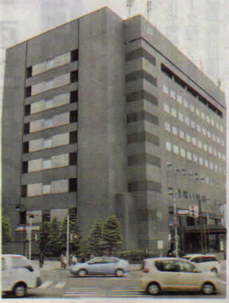
資金調達だけでなく、社内のコスト意識を喚起すべく、一時、売却計画も浮上したJR北海道の本社ビル 札幌市中央区
