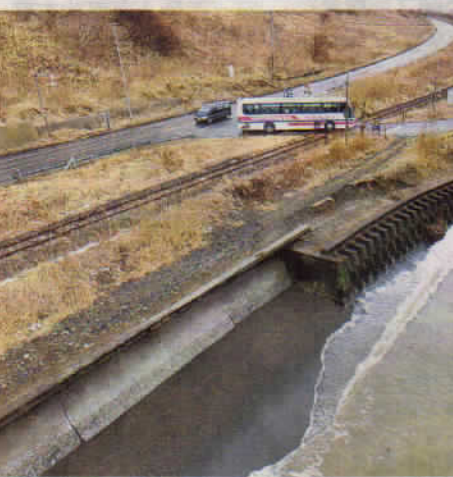
⑤昨夏の高波で土砂が流出し、線路が宙づりになったJR日高線大狩部(おおかりべ)駅付近―昨年12月 ⑥JR日高線節婦(せつぷ)駅近くの護岸。左手前のJRの管轄区間と比べ、右側の公共海岸は整備が進んでいる(小型無人機使用、小川正成撮影)
